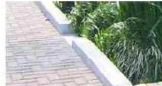
Jardin de pluie à Portland (Oregon-USA) : Ce dispositif permet de déconnecter les eaux de ruissellement des voiries (trottoir) et du bâtiment (photo Mairie de Portland)
