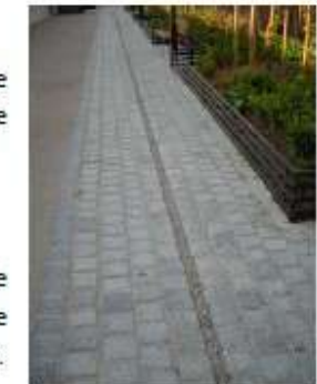
Tranchée d'infiltration dans la ZAC Boucicaut à Paris 15ème
