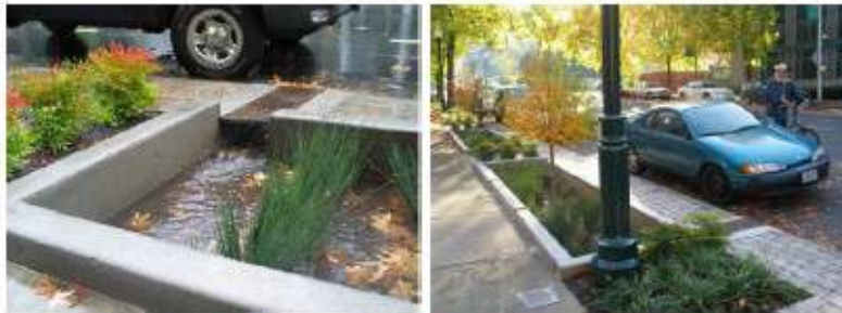
Noues urbaines à Portland (Oregon-USA) : Ce dispositif permet une déconnexion complète des eaux de ruissellement de la chaussée et du trottoir. A noter que les eaux de ruissellement de chaussée sont traitées par les noues basses et les eaux de ruissellement du trottoir par des noues plus hautes (photos et coupe : Mairie de Portland)
