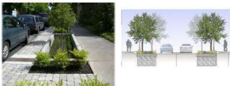
Noues urbaines à Portland (Oregon-USA) : Ce dispositif permet une déconnexion complète des eaux de ruissellement de la chaussée et du trottoir. A noter que les eaux de ruissellement de chaussée sont traitées par les noues basses et les eaux de ruissellement du trottoir par des noues plus hautes (photos et coupe : Mairie de Portland)
