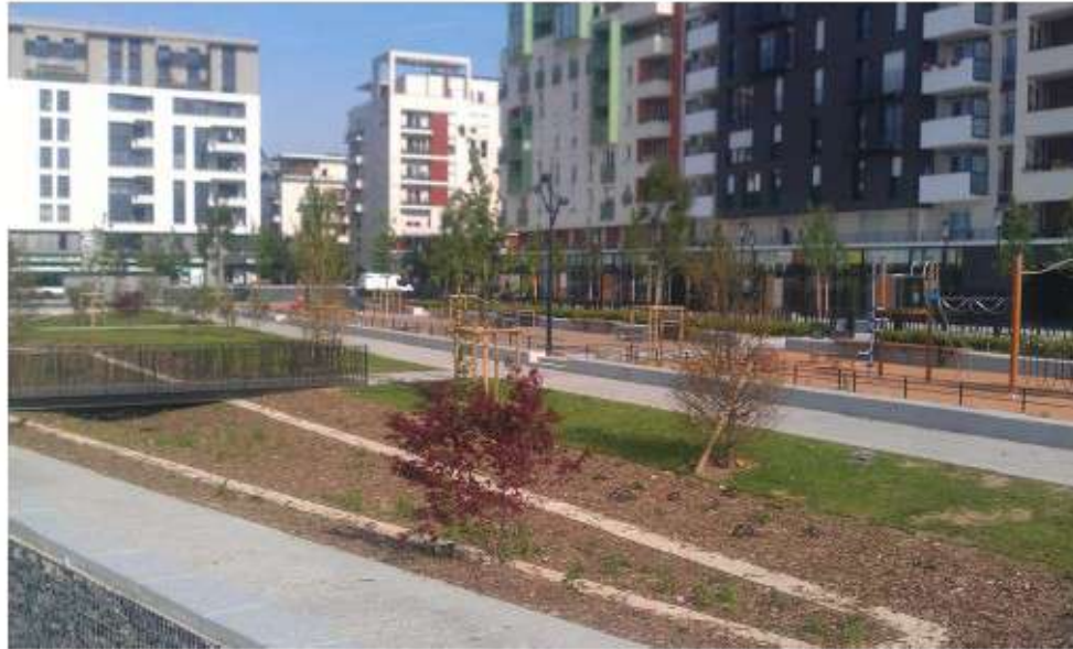
Noue étanche de gestion des eaux pluviales située à l'aplomb de la station de métro Front-Populaire à Saint-Denis (93)(photo de chantier et vue d'artiste).
