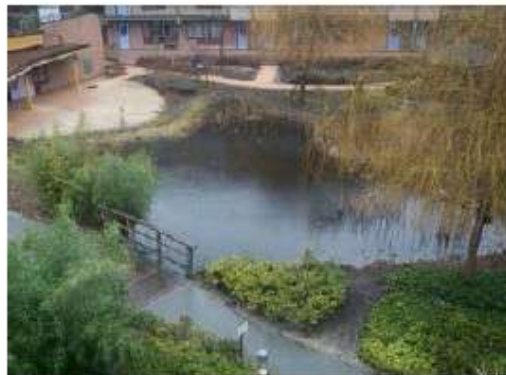
Mare d'infiltration (Source : Erik P.C. ROMBAUT, 2010. « Gestion durable de l'eau en ville. Vers un écopolis résistant au climat »)
