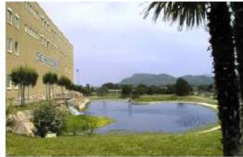
Bassins d'orage paysagers, ZAC de Ferrières, Le Muy à Marseille (photo sté HGM environnement)
