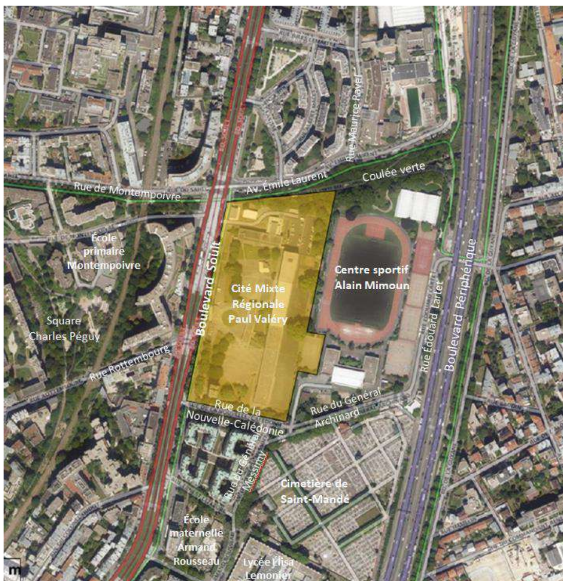
Vue aérienne du site Paul Valéry
