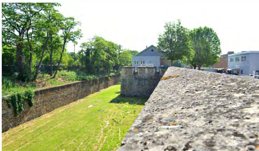
FIGURE 2 : DEUX VUES D'ENSEMBLE DES FORTIFICATIONS, DES DOUVES ET DE LA CONTRESCARPE (SOURCE : DOSSIER DE MISE A DISPOSITION FIG, JUILLET 2021)
