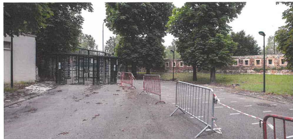
Figure 5 : Entrée nord, illustration du besoin de déclassement de la voirie existante (chaussée et trottoirs) (vue depuis l'intérieur du Fort d'une voirie classée EBC)
