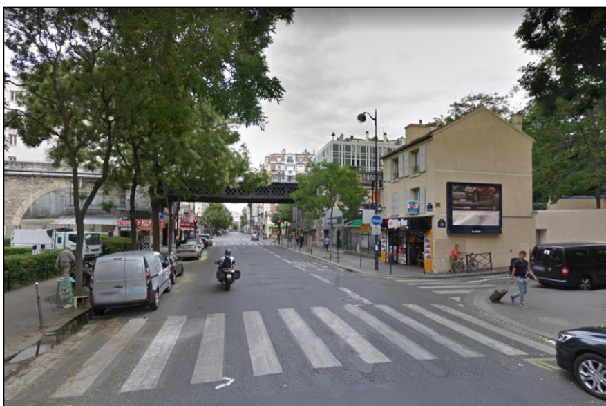
La rue de Vaugirard et le pont-rail de la Petite Ceinture (Google 07/2017)
