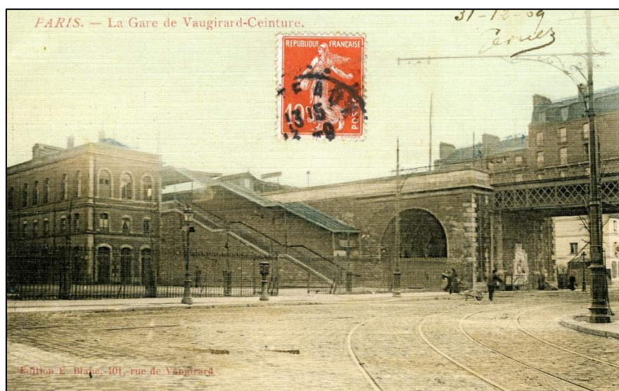
La gare Vaugirard-Ceinture et le pont-rail en 1909
