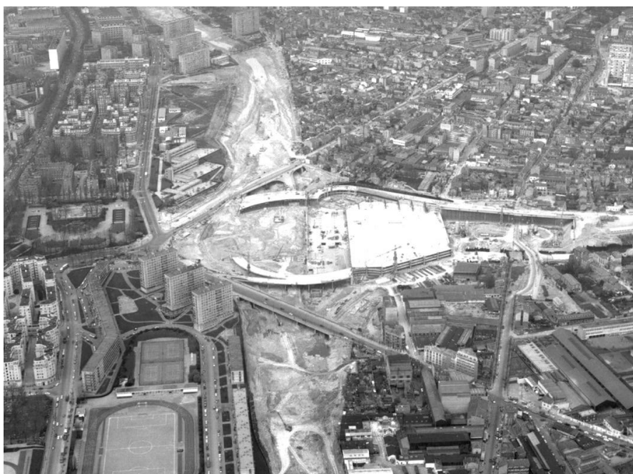
Construction du Boulevard périphérique et de l'échangeur de la porte de Bagnoleet (1968)-APUR
