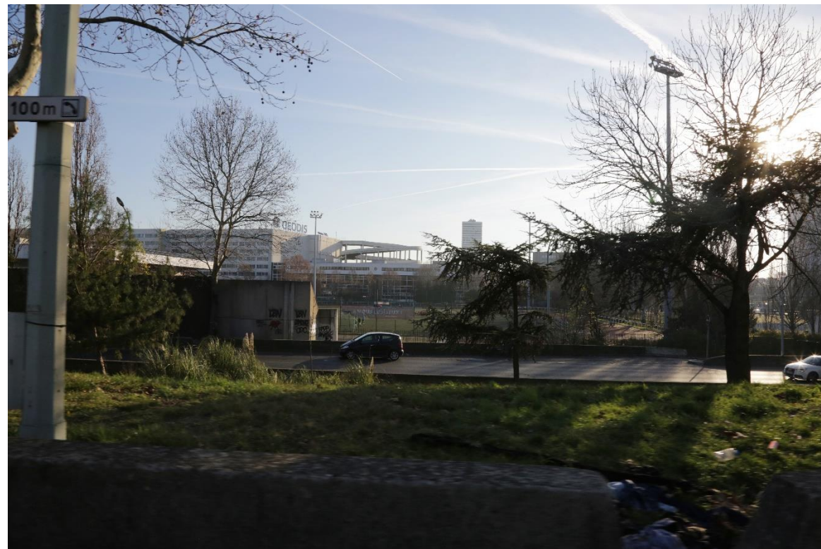
Boulevard Périphérique Intérieur - Stade des fillettes – état initial
