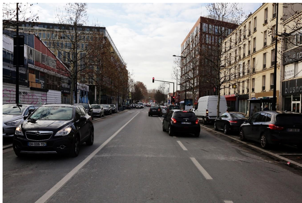
Avenue Victor Hugo – Aubervilliers – état initial
