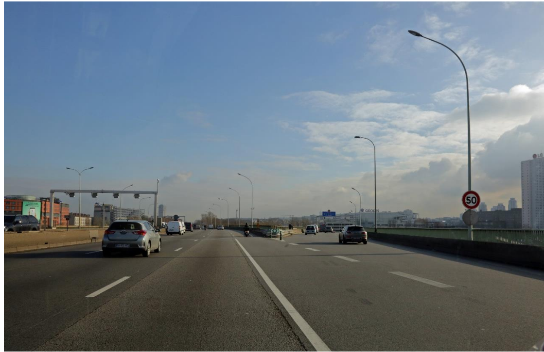
BP intérieur - franchissement faisceau Nord – état initial
