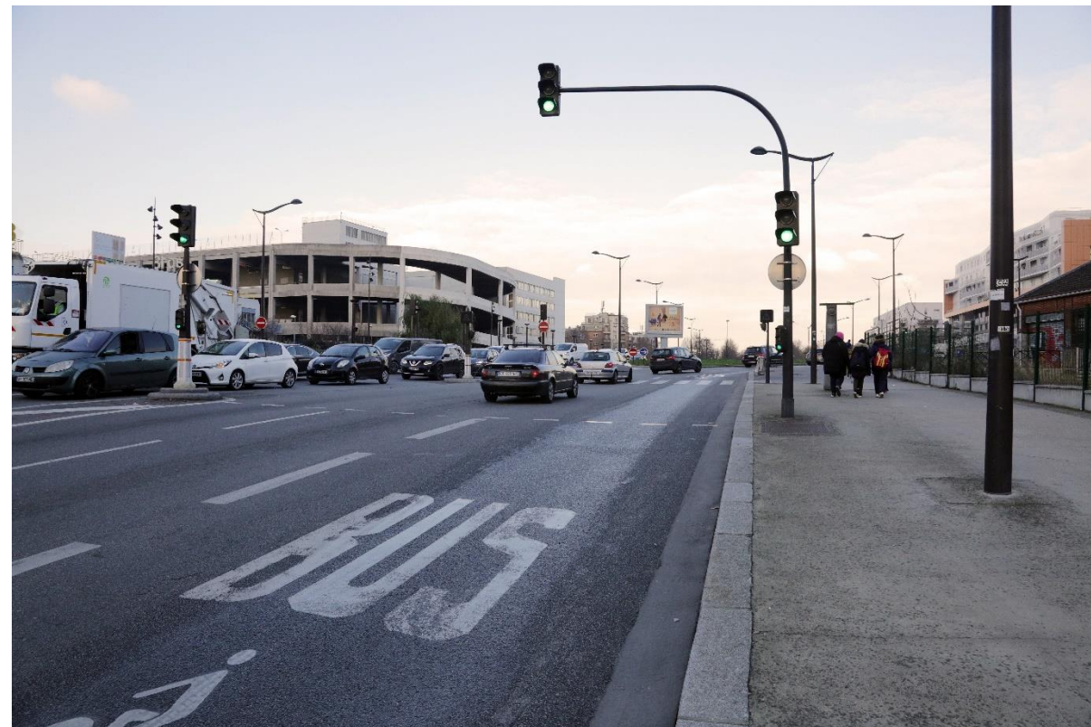
Rue d'Aubervilliers – état initial
