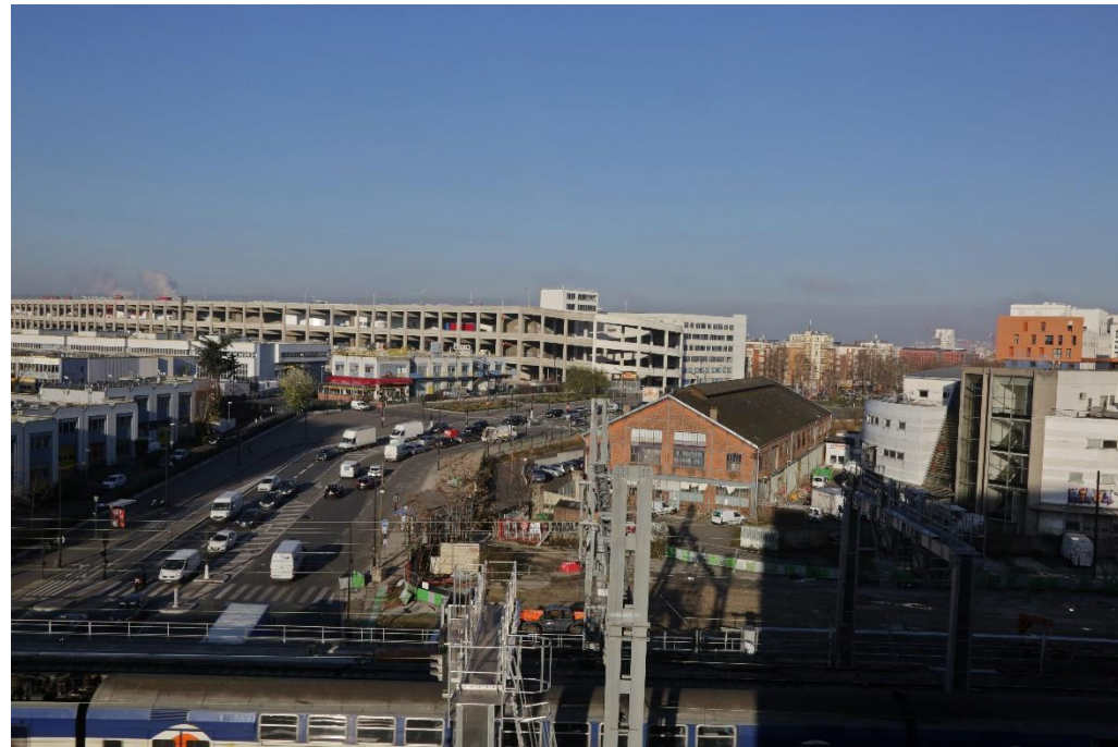
RER Faisceau Est - vers la rue d'Aubervilliers – état initial
