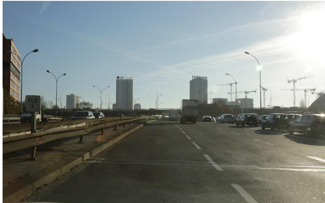
Autoroute A1 - Porte de la Chapelle – état initial
