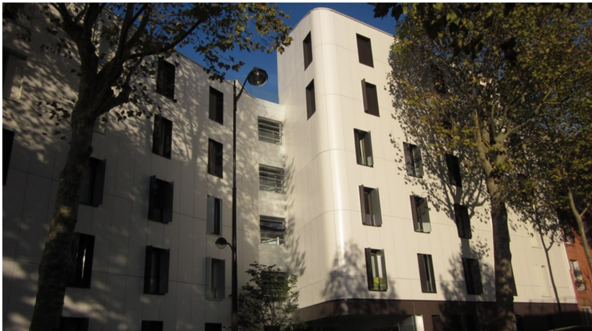
Exemple de constructions récentes (livrées en 2013). Béton banché avec bardage recouvrant une isolation extérieure. Rue Gaston Pinot 75019 Source : APUR
