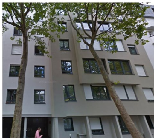
Isolation extérieure d'un bâtiment des années 1980. Rue Saint-Charles 75015. A droite, bâtiment après travaux d'isolation et la fermeture des loggias. A gauche, bâtiment avant travaux. Source : Google street view
