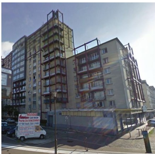
Réfection des loggias et démontage des structures métalliques ajoutées lors de la réhabilitation Palulos. Porte de Vincennes 75020. A gauche le bâtiment avant travaux, à droite le bâtiment après travaux. Source : Google street view
