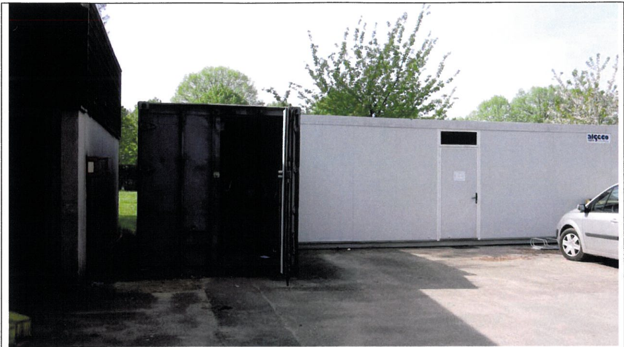
Bureau et conteneurs de stockage (arcs ...)
